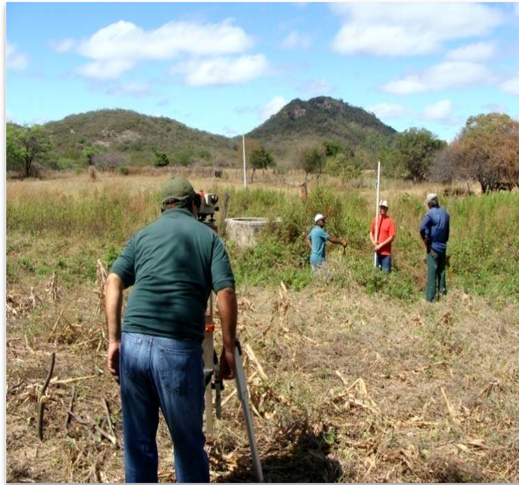
Figura 2. Área da Barragem mostrando o levantamento planialtimétrico.
