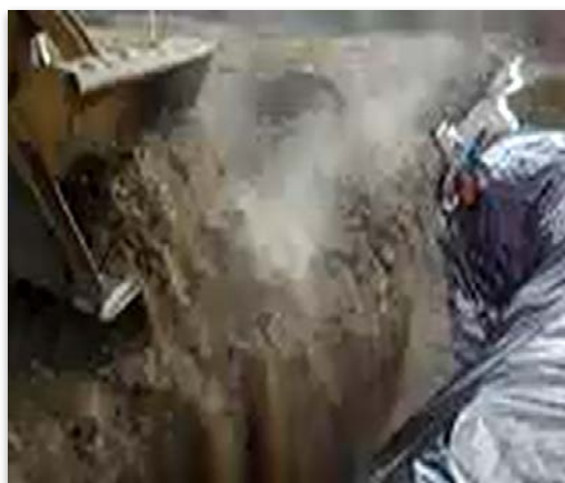
Figura 7. Aterramento da valeta da barragem subterrânea.
